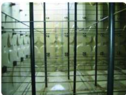
تقویت مخزن با تای رود استیل و لوله
